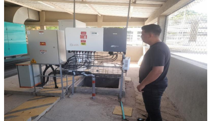
Ilustración 22. Inspección de la instalación del contador bidireccional.
