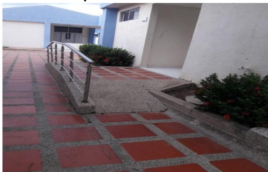
Ilustración 64. Adecuación de acceso a baños
