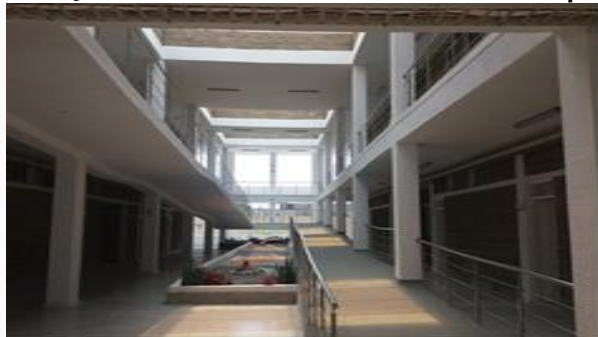
Ilustración 65. Acceso a las aulas de clase nuevo bloque
