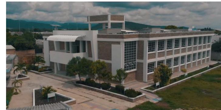
Nuevo Bloque de aulas
