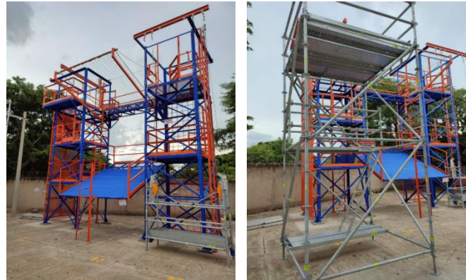
Centro de Entrenamiento de trabajo en Altura
